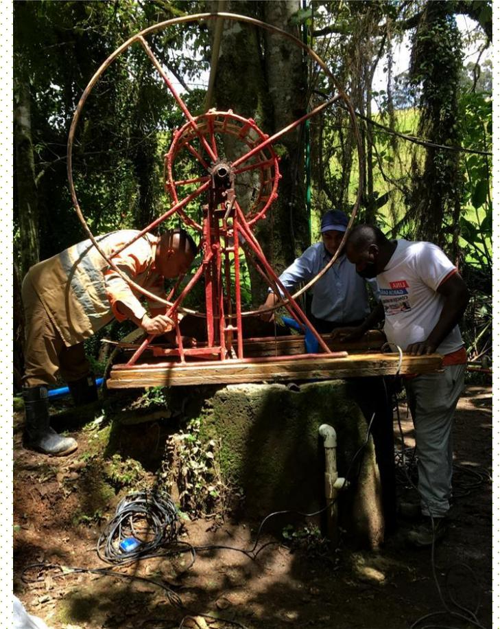
Daño en el pozo de captación de agua, que implicó contratar equipo de pileros para su reparación y recuperación de motobomba sumergible.
